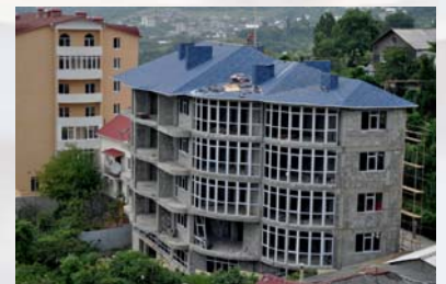
L'utilisation des blocs de béton mousse en construction des hôtels sur l'île Phuket
