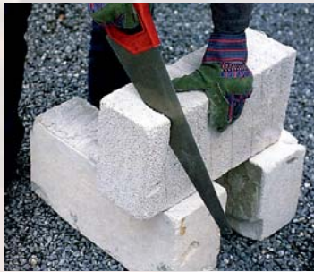
Le portage et le coupage des blocs à main
