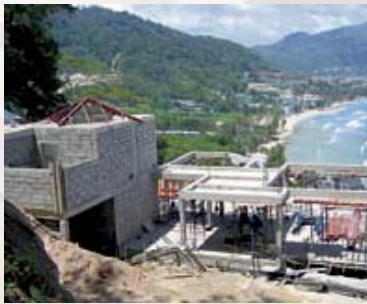
On utilise les blocs de béton mousse en construction des complexes touristiques après le tsunami sur l'île Phuket, Thaïlande
